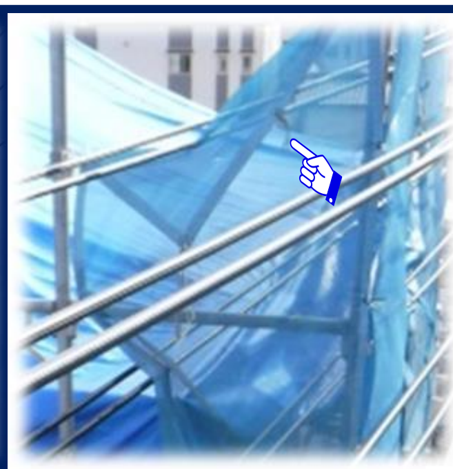
足場が高圧電線の間を貫通 足場が高圧電線に接触
