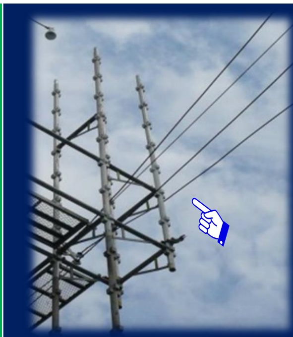
足場が高圧電線の間を貫通 足場が高圧電線に接触
