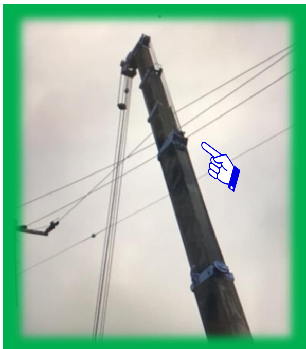
クレーンが電線に接触
