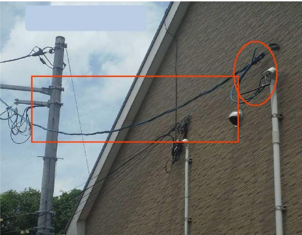
【家屋側 低圧引込線・引込口への防護】⇒取付希望範囲を赤色で示した例です。
