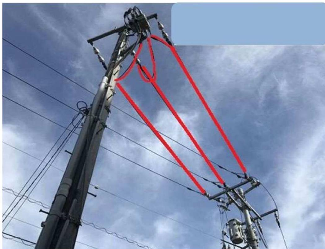
【高圧引込線への防護】⇒取付希望範囲を赤色で示した例です。
