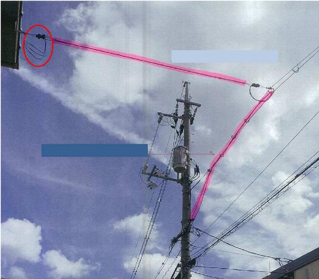
【低圧架空引込線への防護】⇒取付希望範囲を赤色で示した例です。
