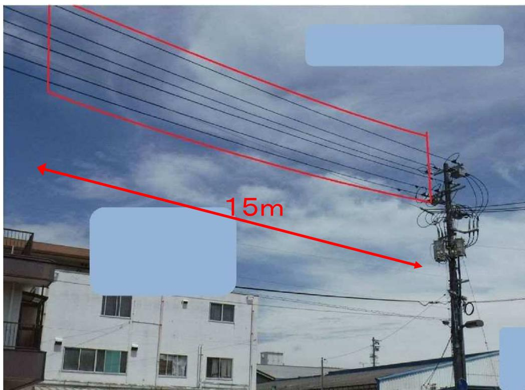
【高圧配電線等への防護】⇒取付希望範囲・長さを赤色で示した例です。
